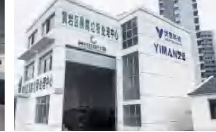
台州黄岩区易腐垃圾处理中心 Taizhou Huangyan District Perishable garbage treatment Center Capacity/处理量：12t/日(d)
